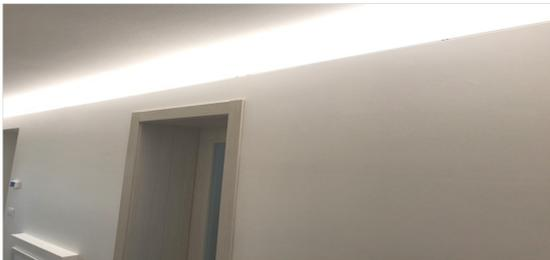
Un'applicazione architettonica della striscia LED HS14 è di fissarla all'interno di un profilo in alluminio con copertura in policarbonato opale, quindi montarla rivolta verso l'alto su una nicchia ricavata nella parete di cartongesso. La luce viene riflessa dal soffitto e distribuita in modo efficace e senza abbagliamento in tutta la stanza.
