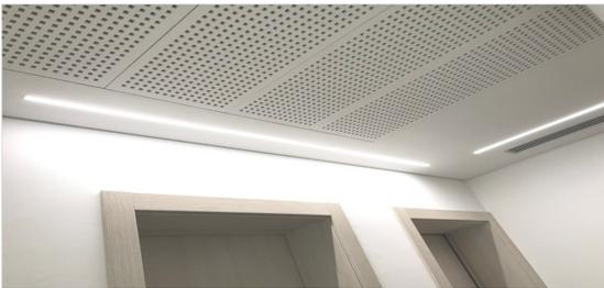
Montaggio della striscia led HS14 nei profili in alluminio da incasso per cartongesso con policarbonato opale, questa applicazione rende l'illuminazione della stanza in un modo eccellente ed elegante.
